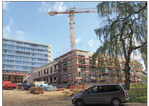
Der Verwaltungstrakt nimmt Form an.
