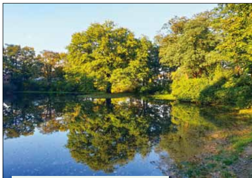
Am Rückhaltebecken Hausbruch
